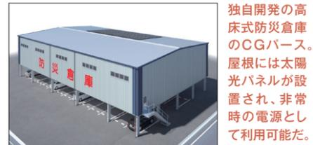
独自開発の高床式防災倉庫のCGパース。屋根には太陽光パネルが設置され、非常時の電源として利用可能だ。
